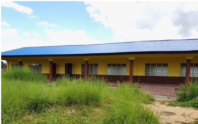
Het nieuwe Sciencegebouw voor SDA SS Yele
