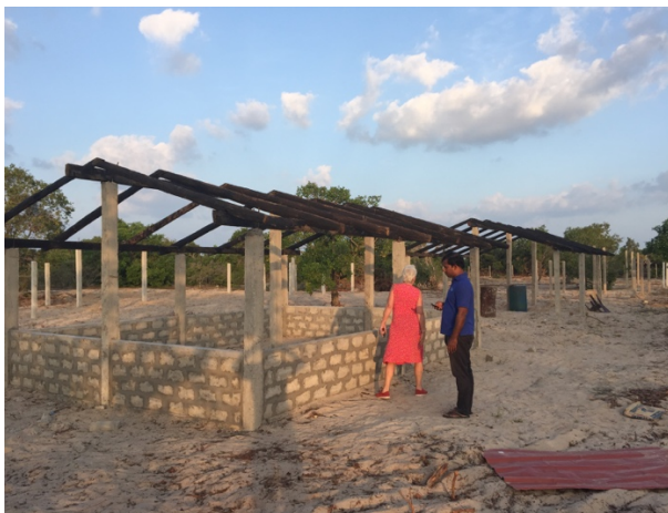
De kippenhokken in aanbouw
